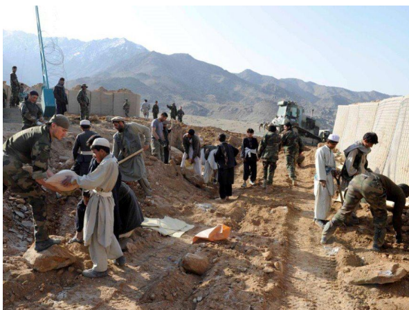
Construction de la Base Belda
