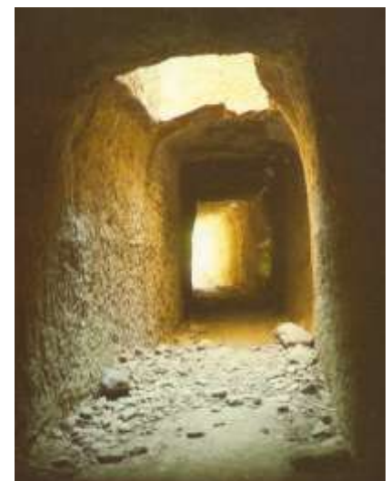
Tunnel de Senhas – L, 300m
