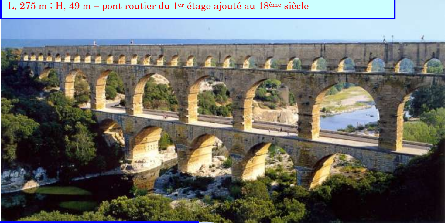
Conduit supérieur où passait l'eau
